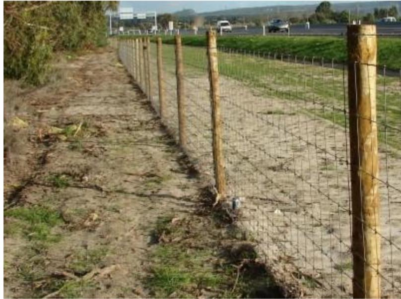
Photo 3 : Exemple de clôture avec grillage mouton et piquets en bois
